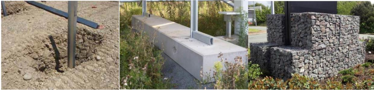
Figure 5 : Types de fondation : pieux battus (gauche), semelle béton (centre), gabion (droite) (Source : Guide MEDDTL 2011 – NCA, 2015)
